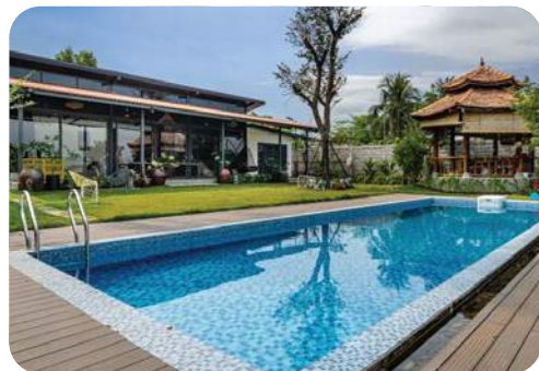
Thi công nhà ở Dân dụng và công nghiệp Thi công cảnh quan sân vườn, hồ tiểu cảnh Thi công hồ bơi dân dụng và công nghiệp
