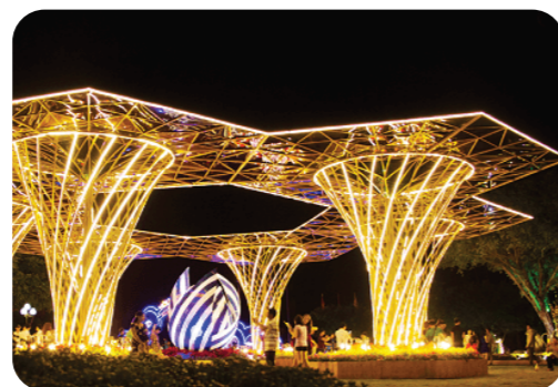
Thi công trang trí đèn chiếu sáng
