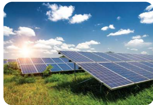
Thi công năng lượng mặt trời
