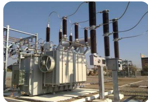
Lắp đặt trạm biến áp
